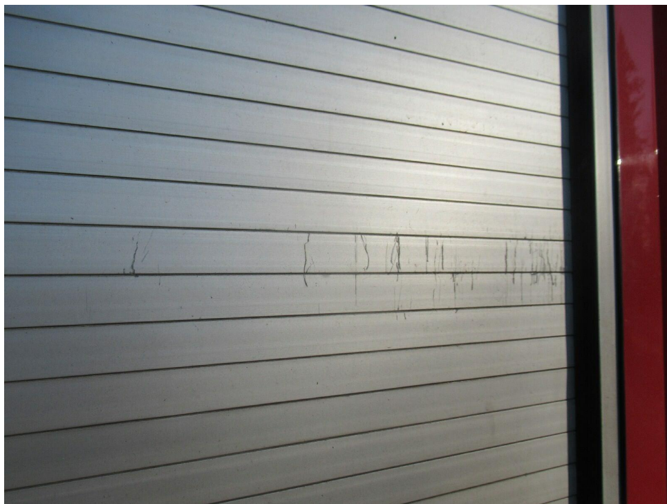
Bild 32 : Rollläden zerkratzt
