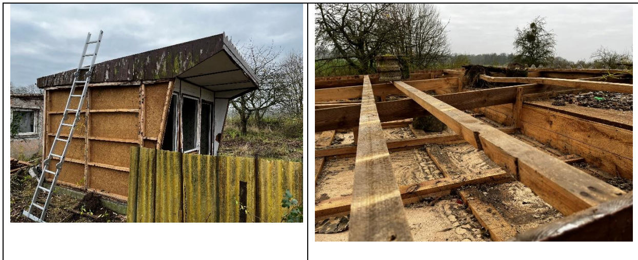
Abbildung 3: Gartenlaube mit entfernter äußerer bzw. oberer Schale, PfaU GmbH 12.11.24
