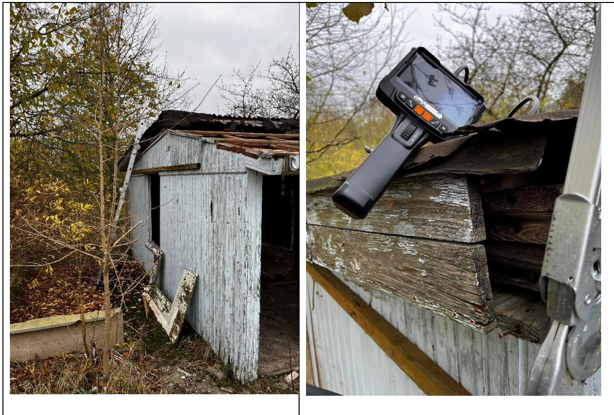
Abbildung 5: Gartenlaube, wo sich die eine Hälfte der oberne Dachschale nicht so entfernen ließ, dass die gesamte Dachkonstruktion zerstört worden wäre, PfaU GmbH 12.11.24
