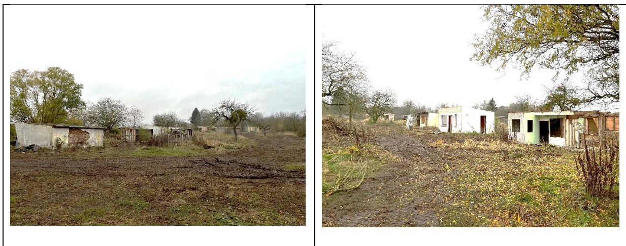
Abbildung 2: repräsentative Ansichten der teils zurückgebauten Gartenlauben und der teils geräumten Kleingartenanlage, PfaU GmbH 12.11.24
