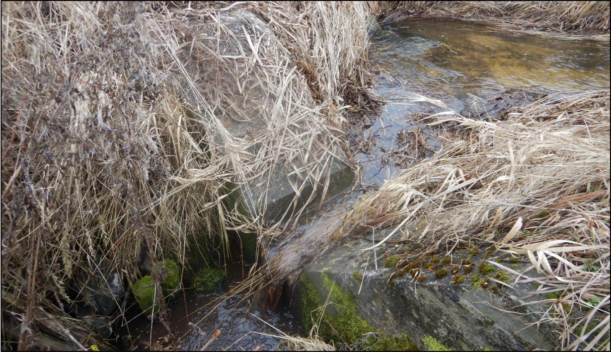
Abbildung 4-3: Bauwerk, welches den Hauptwasserfluss in über den Graben 660/30 Richtung Bruchwald führt.
